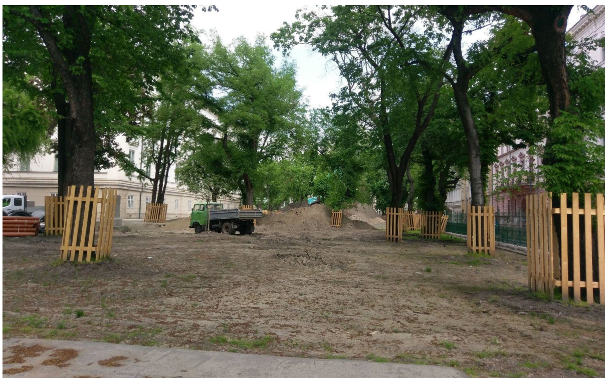
Fig. 11 - Exemplificare referitoare la protejarea Zonei radiculare Critice (ZRC) pe parcursul lucrărilor de amenajare: soluție cu împrejmuire realizată din lemn
