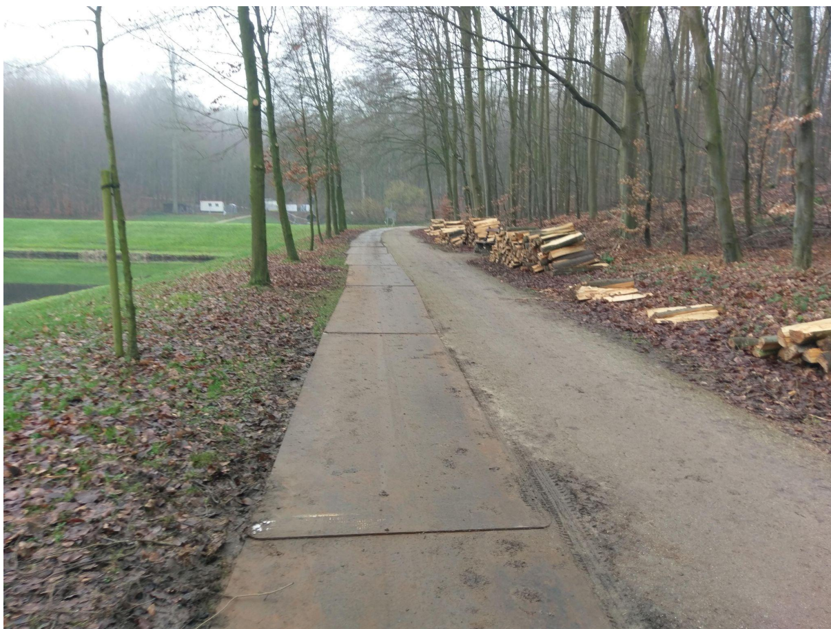
Fig. 6 - Exemplificare a modului în care poate fi protejat solul pe parcursul realizării intervențiilor în zonele pe care se deplasează echipamentele grele: soluție tehnică în care sunt utilizate foi groase de tablă
